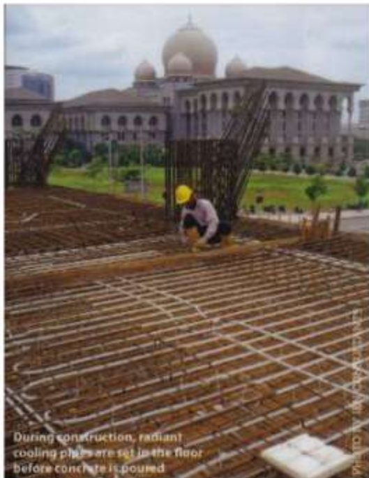
地板制冷系统埋设在加强混凝土楼板中
